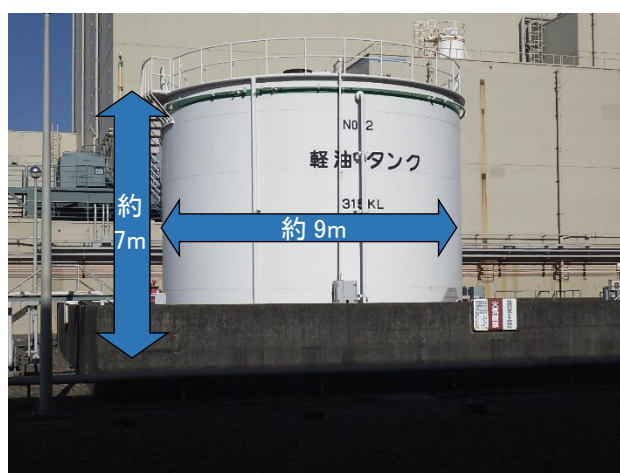
軽油タンク外景(解体前)
